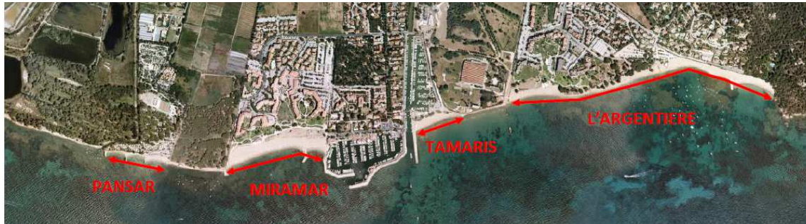
Figure 2-49 : Emprises des plages rechargées (source : C. Belmont, Safege).
